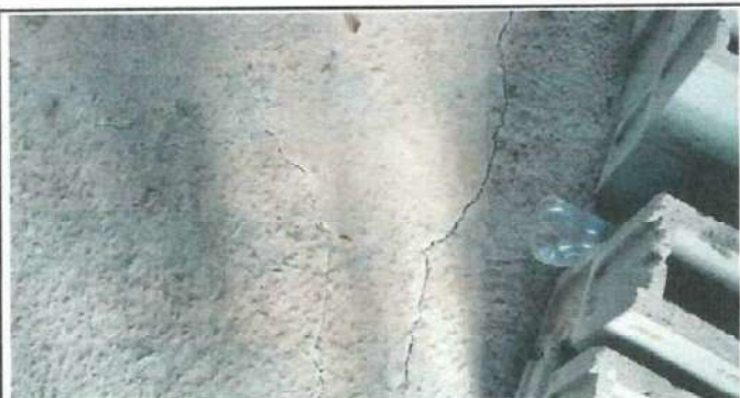
Foto 3: Cambio de piso.
