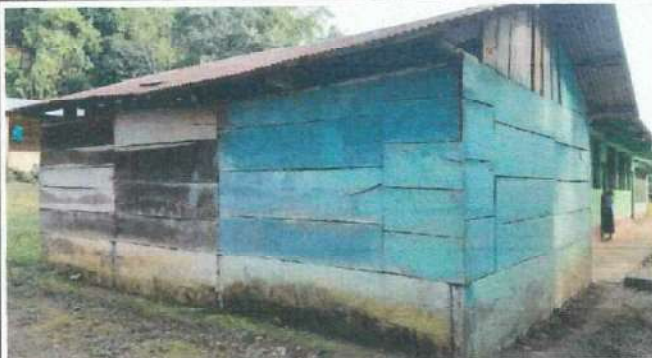
Foto 2: Aplicación de pintura.
